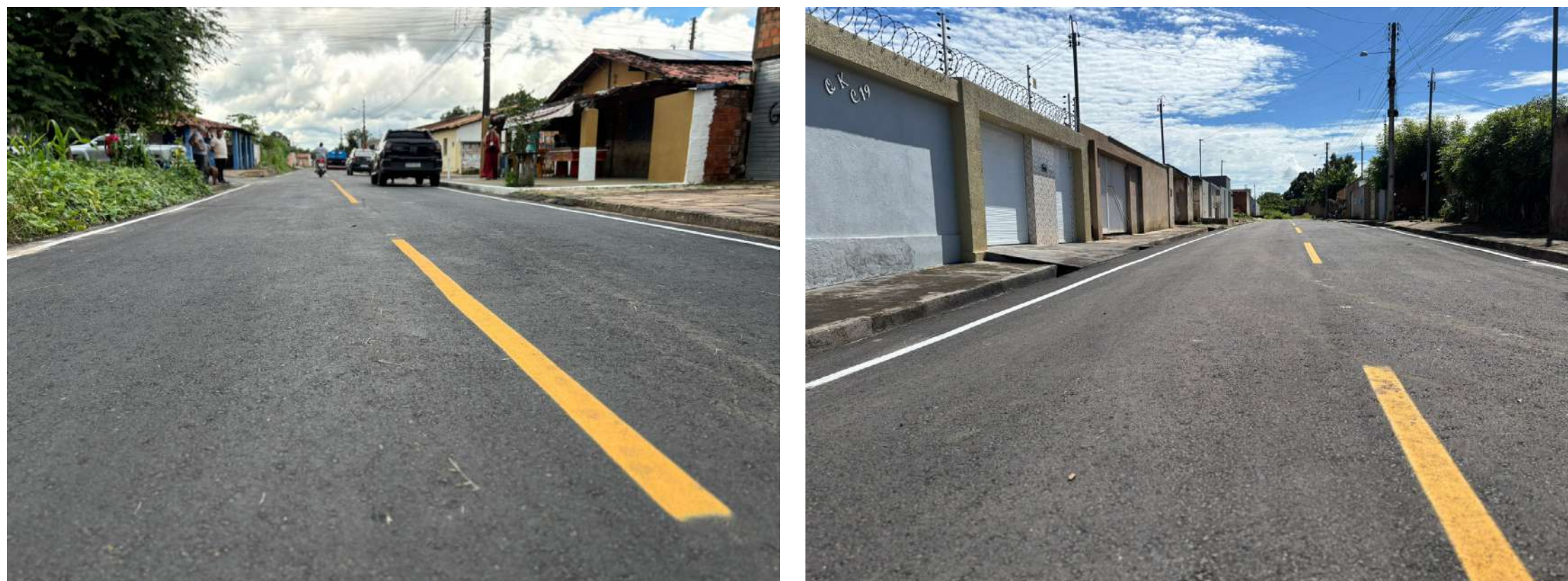
Figura 6 - Pavimentação asfáltica em Piripiri
