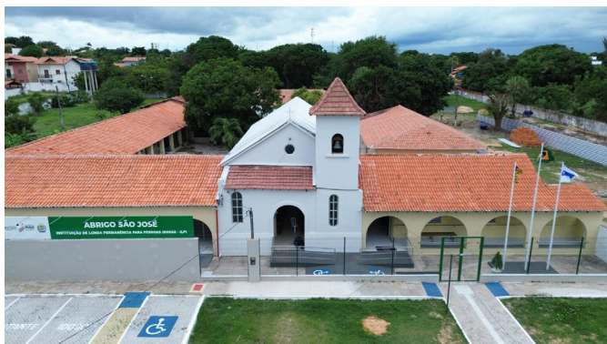
Figura 32 – Reforma e ampliação do Abrigo São José.
