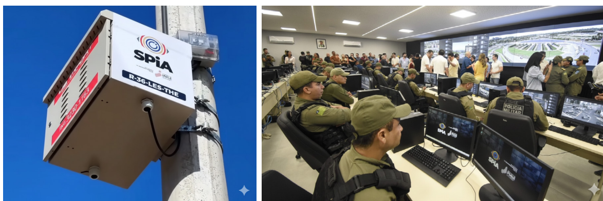
Figura 27 - Câmera de Videomonitoramento Urbano e Centro Integrado de Comando e Controle.
