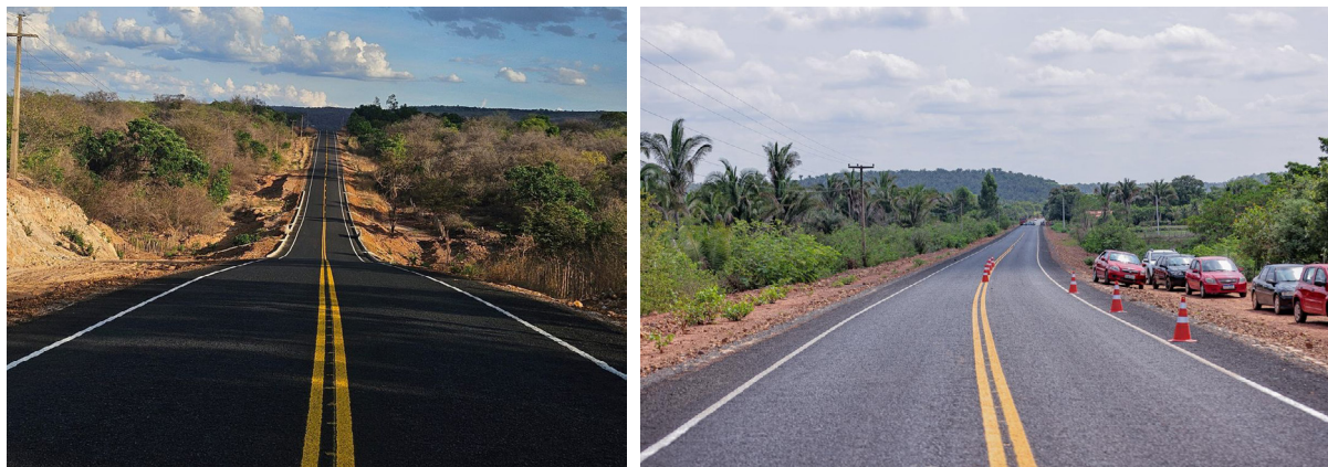
Figura 34 – Pavimentação asfáltica da PI-225 trecho Aroazes e Santa Cruz dos Milagres e São Miguel do Tapuio e Pavimentação asfáltica da PI-110 trecho Barras e Miguel Alves.
